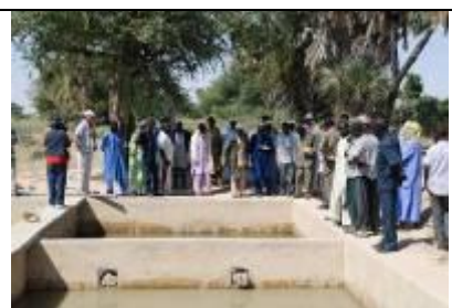
Bassins en ciment (Diffa)
