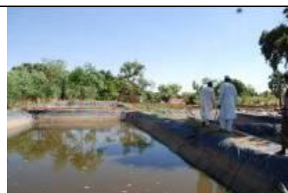
Bassin avec bâches (Tillabéri)
