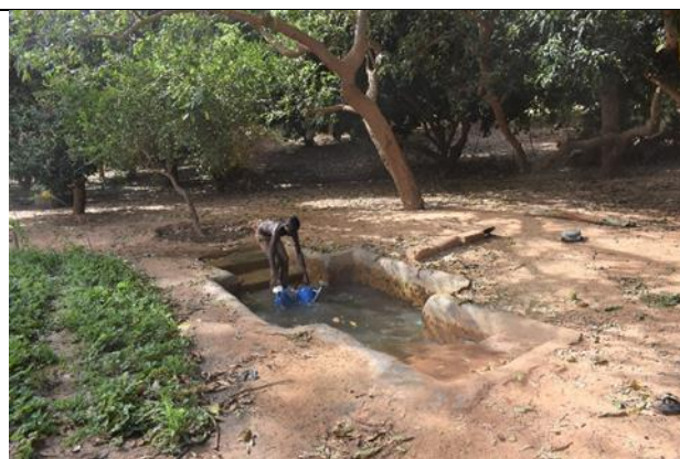
Bassin construit par les producteurs, adapté au remplissage des arrosoirs.
