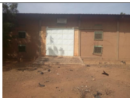
Photo n°2 : Même magasin de conservation (photo 2019).
