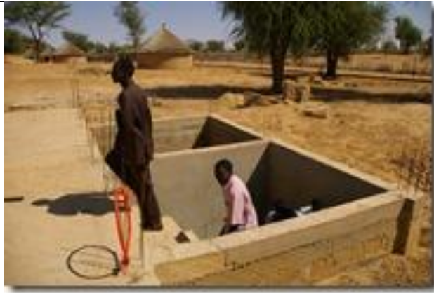
Photo n°3 : Magasin de conservation en cave / jamais terminé (photo de 2009).
