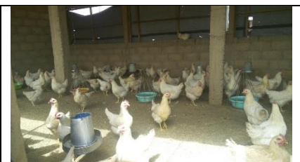
Vu de l'intérieur, mur trop haut et ne facilitant pas la ventilation en période chaude.
