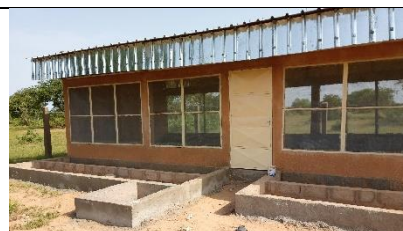
Taille du muret correcte et ouvertures importante facilitant la ventilation.
