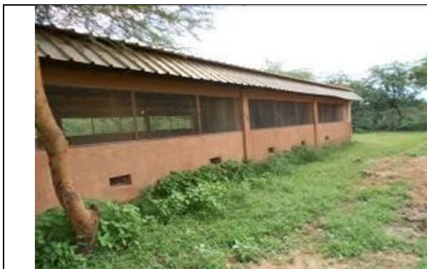
Photo 6 : bâtiment avicole avec auvent de protection
