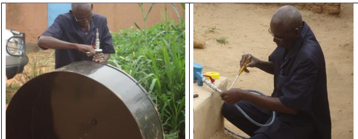
Photo 4 : Branchage et installation des accessoires du biodigesteur
