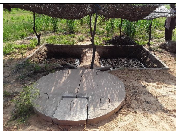
Photo 3 : Digesteur et cuves de sortie du digestat
