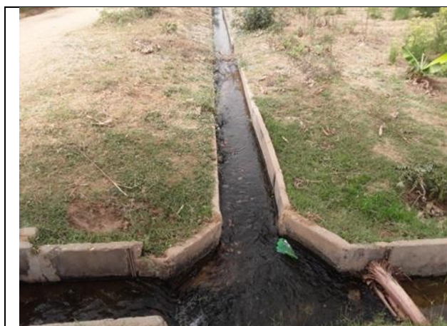
Canal d'irrigation au niveau de périmètre de Djirataoua
