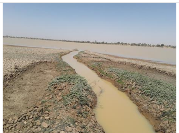
Canal de cheminée au niveau de la mare de Madarounfa
