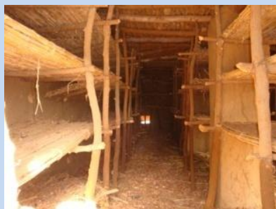
Abri de conservation de type RESEDA vu de l'intérieur
